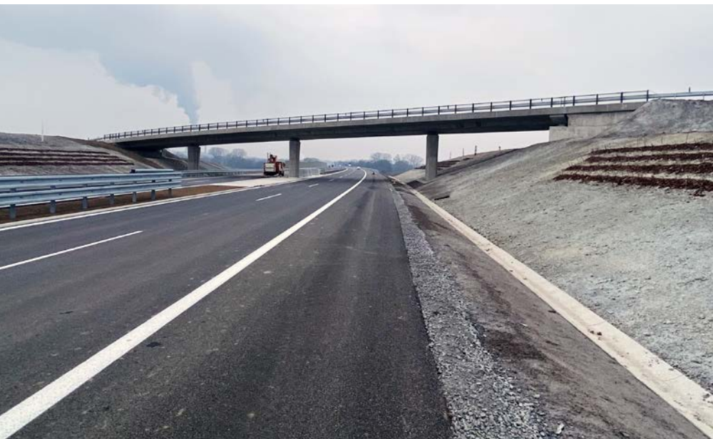
Úsek dálnice D35 Opatovice – Časy realizovaný společností M – SILNICE a.s. předaný do předčasného užívání v prosinci 2021
